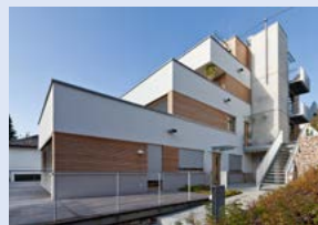
Mehrfamilienhaus als Terrassenhaus, Zell-Weierbach
